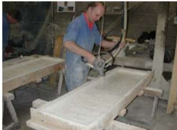
۲. اسپری کردن GFRG روی قالب
